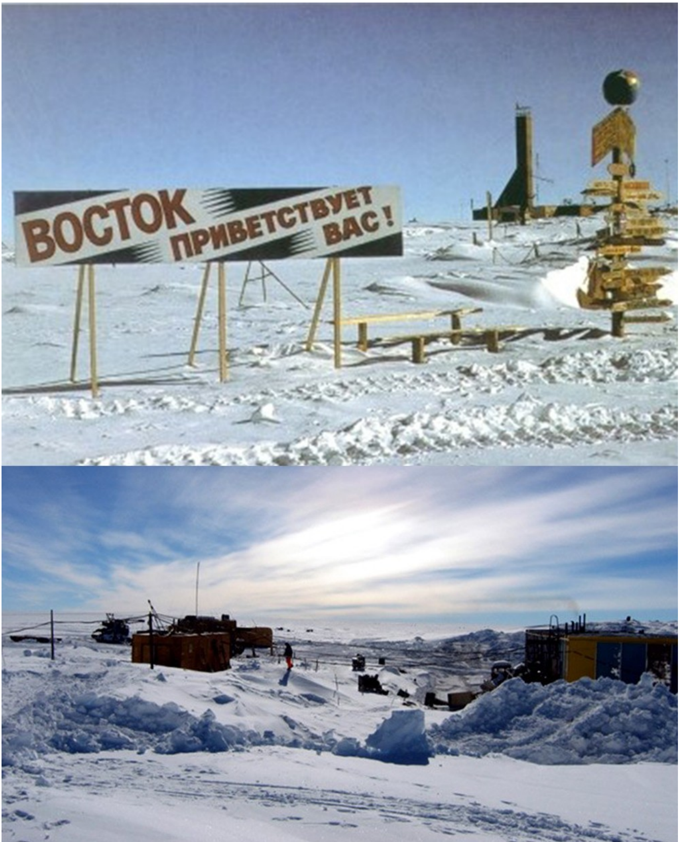
FIGURAS 4a e 4b - Tomadas fotográficas da Base Vostok, com a placa em russo saudando os visitantes ( Vostok: Cumprimentos da Base! ) e instantâneo da ala Sul das instalações durante o verão antártico (Fotos: Pinterest, < https://br.pinterest.com/ >. Acesso: 13-02-2018).
