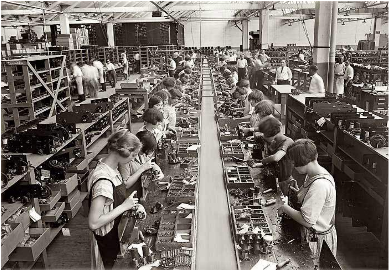
FIGURA 8 - Instantâneo de uma linha de montagem ( Assembly Line ) de uma indústria de aparelhos de rádio nos Estados Unidos nos anos 1920. Embora as linhas de produção tenham surgido primeiramente na indústria automobilística por conta das inovações introduzidas por Henry Ford, não tardou que o conjunto dos parques industriais adotassem a nova organização laboral em todo o universo fabril. Aliás, note-se na foto a reprodução das dicotomias tradicionais de gênero e de poder: a linha de montagem, tal como em muitos outros estabelecimentos industriais é exclusivamente feminina, que também indexava dessimetrias étnicas (Fonte: < http://hhdesign.com/blog/2015/1/16/henry-ford >. Acesso: 21-08-2018).
