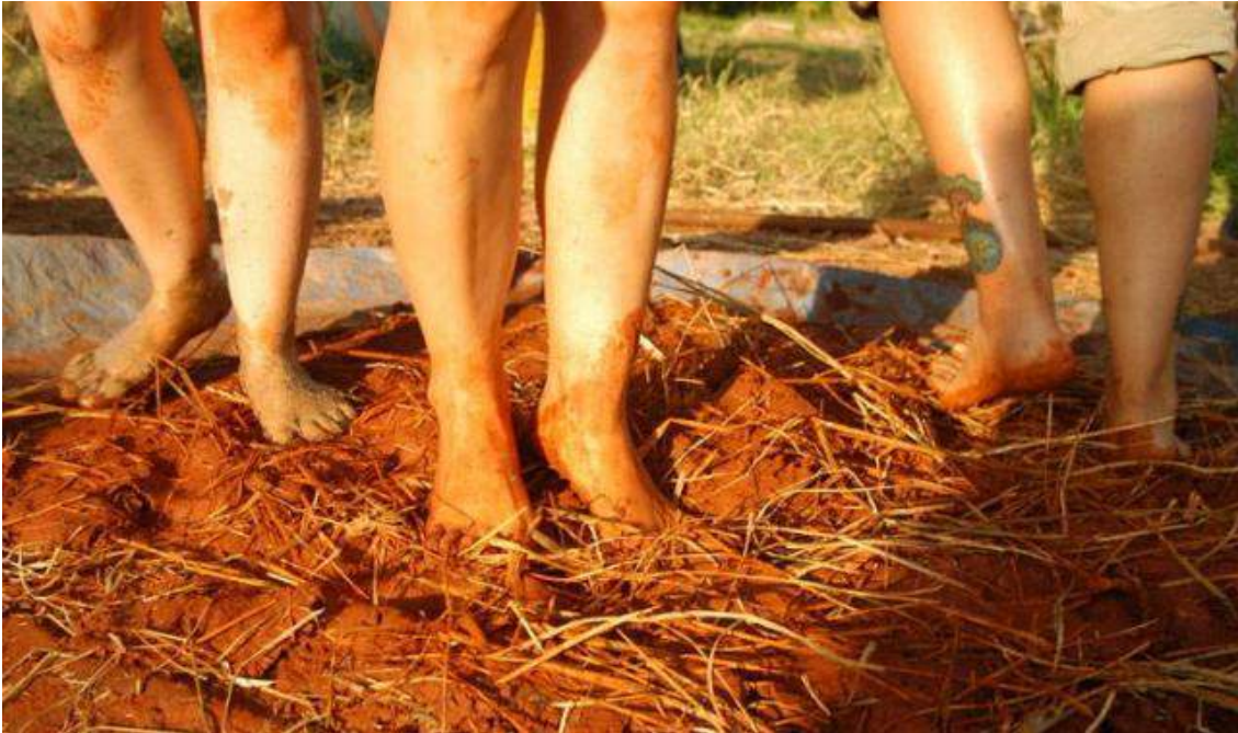
FIGURA 7 - Mistura da massa do adobe por pisoteamento, prática comum nas técnicas brasileiras rurais de adobe (Foto: http://lecycpicorelli-bioarquitetura.blogspot.com.br/2011/06/construcao-de-terra-parte2-adobe.html#axzz4VPPEo9of ).
