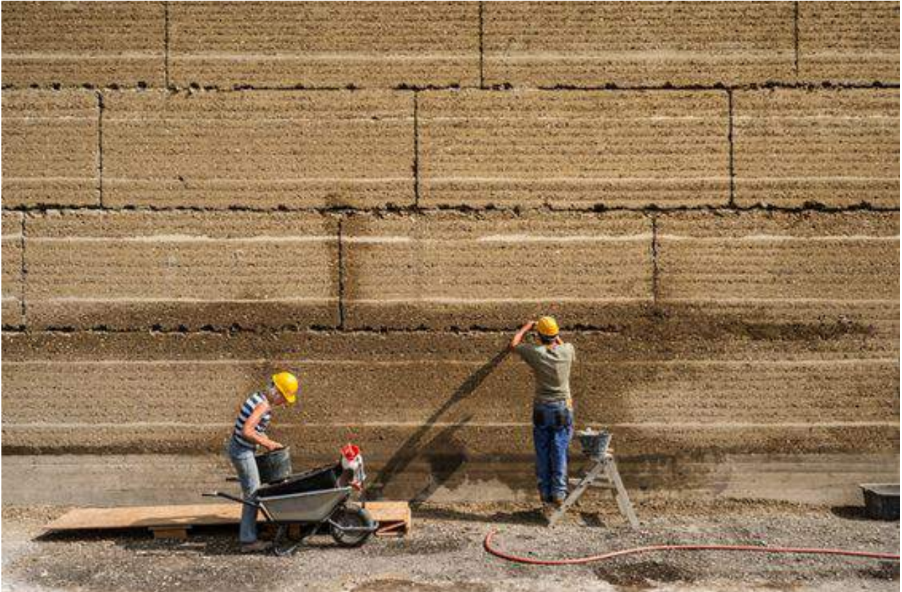
FIGURA 6 - Muro de terra crua construído na República Popular da China. Neste país, a earth architecture é um método bastante praticado, principalmente nas áreas rurais. Na foto, operários dão acabamento na obra. Notar o desenho da alvenaria, resultante do socamento por etapas de cada trecho do muro (Foto: Architectmagazine.com, in Pinterest).
