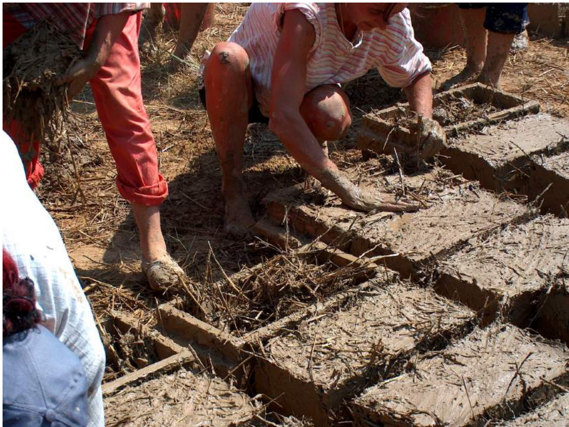
FIGURA 8 - Modelagem manual de adobes em formas na região do delta do rio Danúbio, na Romênia. Note-se a diferença de coloração da massa, assim como a proporção de colmos comparativamente à imagem anterior (Foto: http://planetsave.com/2016/08/12/adobe-abcs-green-building-materials/ ).
