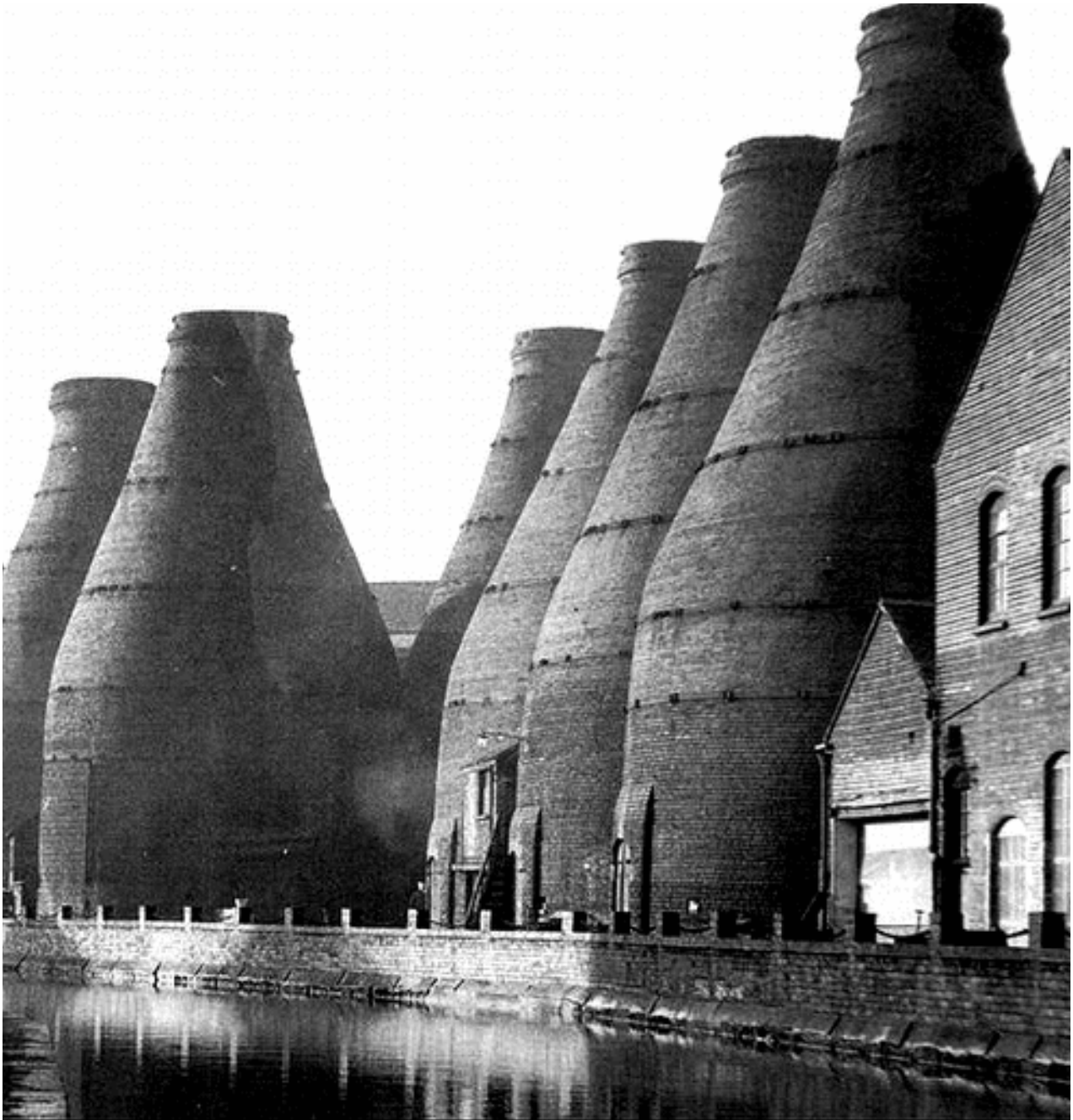
FIGURA 15 - Chaminés de fornalhas para queima de tijolos tipo bottle kiln (forno garrafa), fotografadas na paisagem britânica de Stoke-on-Trent nos anos 1950. Este centro urbano foi um importantíssimo polo cerâmico da Inglaterra, atividade que imperou na cidade a partir dos finais do Século XIX. No apogeu, podiam ser contadas 4.000 bottle kilns na área urbana, gerando trabalho para dezenas de milhares de operários, grande parte dos quais eram imigrantes italianos. Atualmente restam 47 bottle kiln , preservadas para recordar a fase áurea da indústria tijoleira na cidade (Foto: Patrizia Centofani, 1958, in Pinterest).
